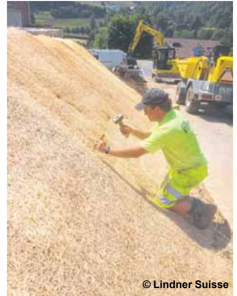
Holzwolle wird mit Holznägeln fixiert.
