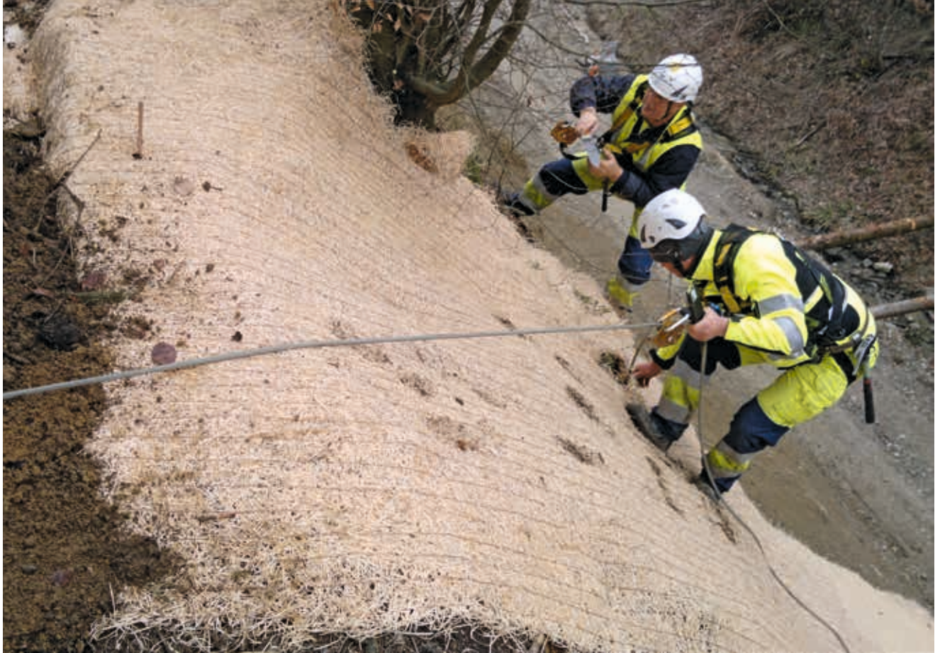
Zum Einsatz von Holzwolle als Böschungssicherung laufen verschiedene Versuche.
