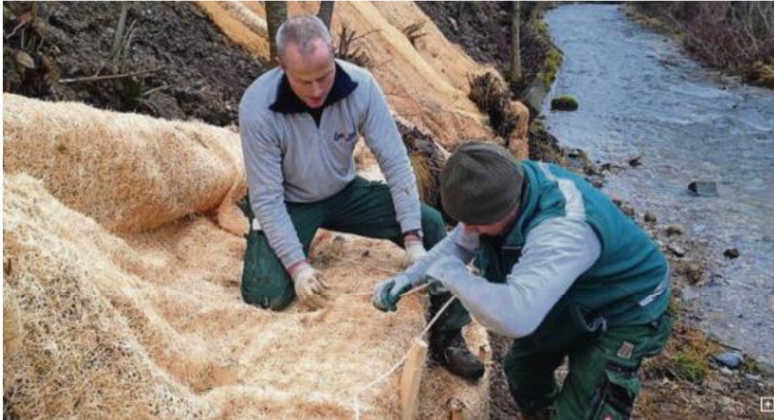
Die Q-Faschinen werden entlang des Ufers verlegt und befestigt. (Bild: pd)
