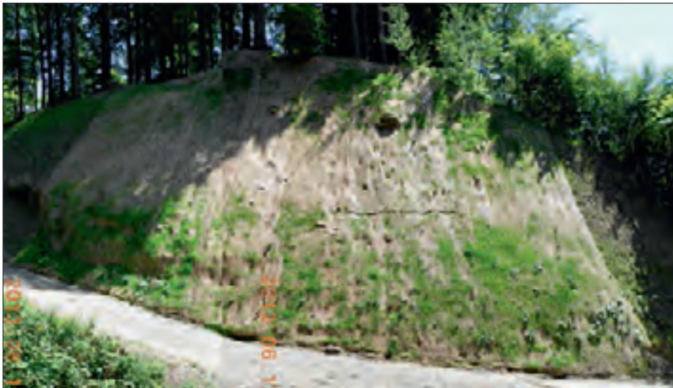
Abb. 16: Zustand der Versuchsfläche zweieinhalb Monate nach dem Einbau, Bild Kurt Hollenstein
