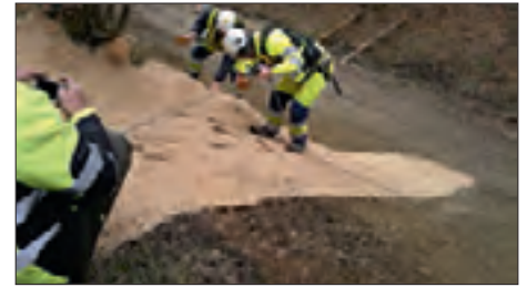
Abb. 11: Vernagelung der Matten am Hang Fig. 11: Clouages des nattes dans le talus
