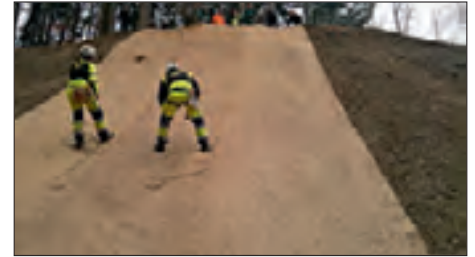
Abb. 13: Fortsetzung der Installation Fig. 13: Suite de l'installation
