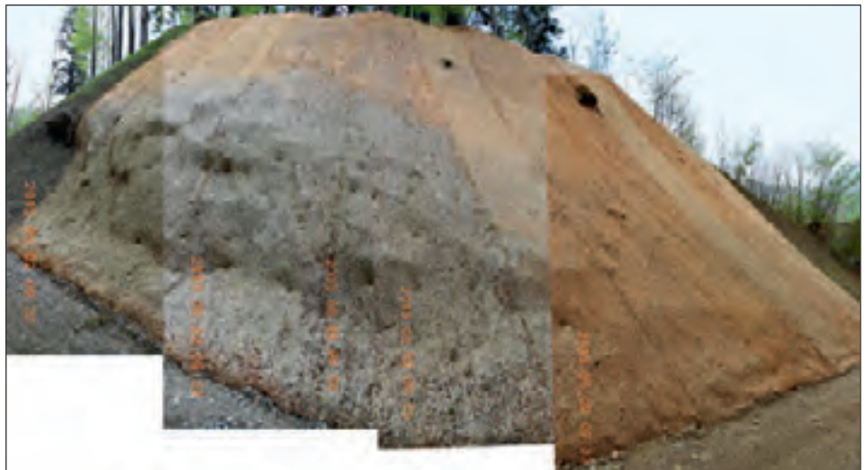
Abb. 14: Zustand der Versuchsfläche einen Monat nach dem Einbau, Bild Kurt Hollenstein Fig. 14: Etat de la parcelle expérimentale un mois après son installation
