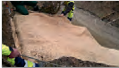
Abb. 10: Verankerung der Matten Abb. 10: Ancrage des nattes
