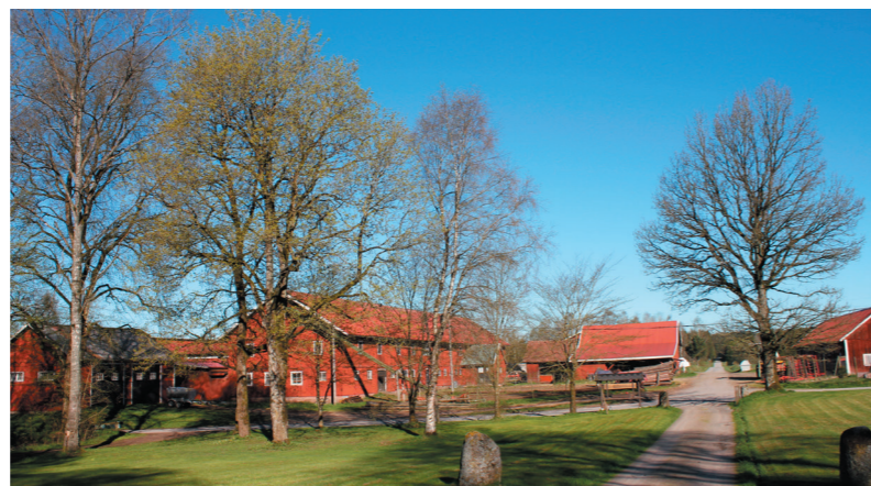
Der Borrarps Gård (Hof) in seiner ganzen Pracht vom Wohnhaus aus gesehen. Der neue Kuhstall liegt hinter den alten Wirtschaftsgebäuden.
