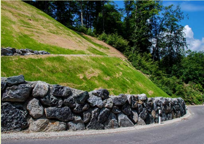
Erosionsschuttmatten bei steilen Böschungen.
