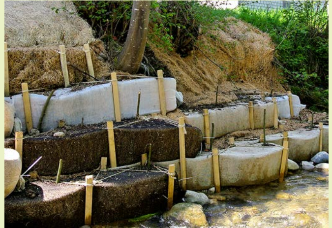
Holzwollesfaschine, umhüllt mit einem Baumwollgewebe.
