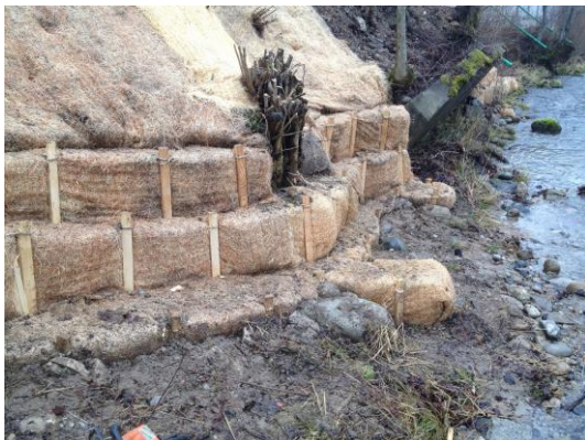
Image 05_fascine Howolis Q : Les fascines en laine de bois flexible permettent de poser le matériau tout le long de la ligne de rivage individuelle. Les éléments rugueux, tels que les épis et les éperons, peuvent également être modelés.
