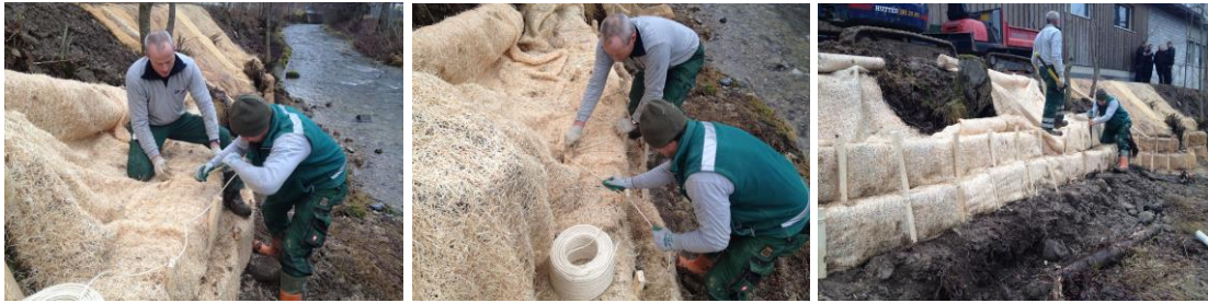
Image 02/03/04_fascine Howolis Q : Pose des fascines Q, piquetage et fixation de la fascine le long de la rive.
