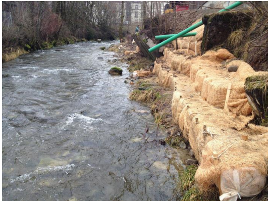
Image 01_fascine Howolis Q : Sécurisation de l'aménagement des berges avec les fascines Howolis Q (les tuyaux verts permettent provisoirement d'évacuer l'eau)
