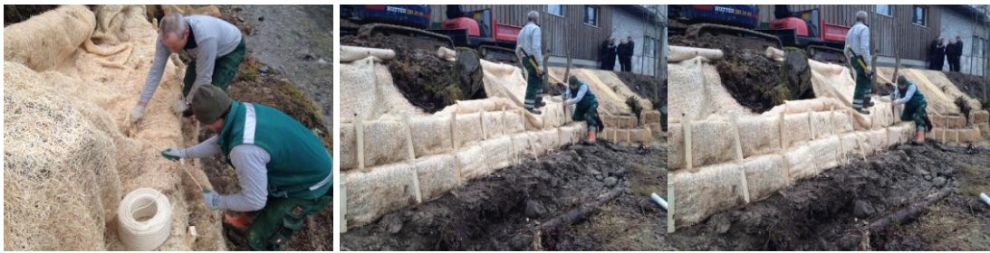
Figura 02/03/04_Fascine Howolis Q: posizionamento delle fascine Q, impalatura e fissaggio delle fascine lungo la sponda.
