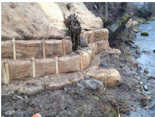
Figura 05_Fascine Howolis Q: le flessibili fascine in lana di legno possono essere estese a seconda della linea naturale della sponda. Allo stesso tempo è possibile modellare elementi che favoriscono la rugosità, come pennelli e speroni.
