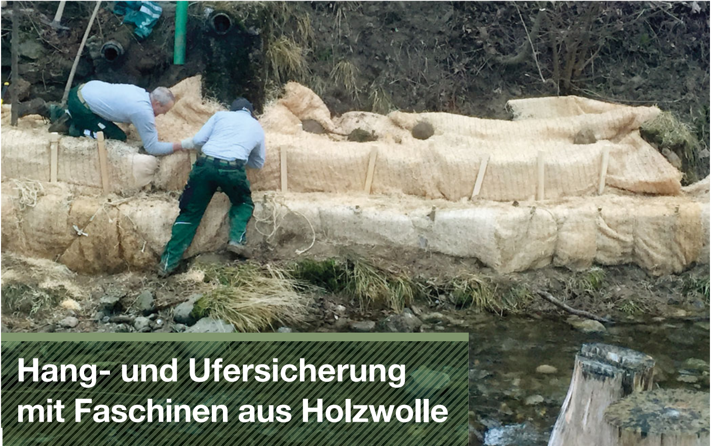
Installation der Holzwollefaschinen.
