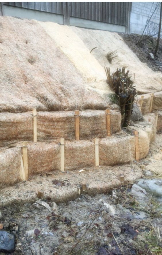
Hang- und Ufersicherung mit Holzwolle-Matten und Faschinen.
