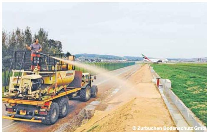
La laine de bois sur un escarpement est aspergée d'hydro-ensemencement à l'aide d'une machine.
