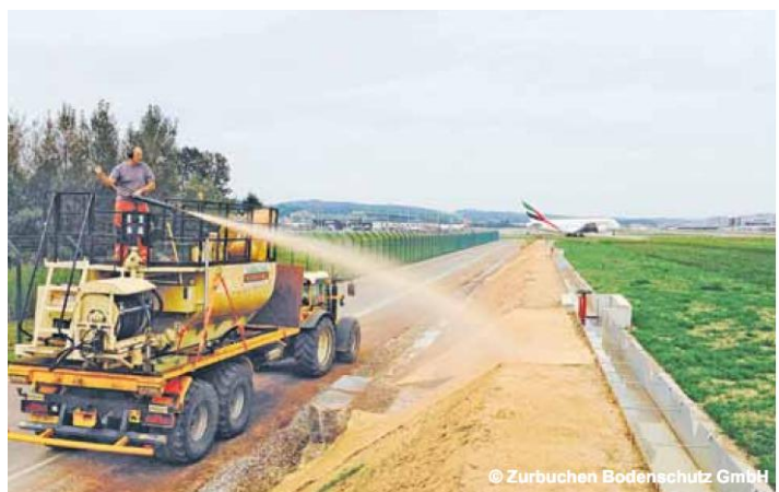
La lana di legno posta su un pendio viene spruzzata meccanicamente con idrosemina.
