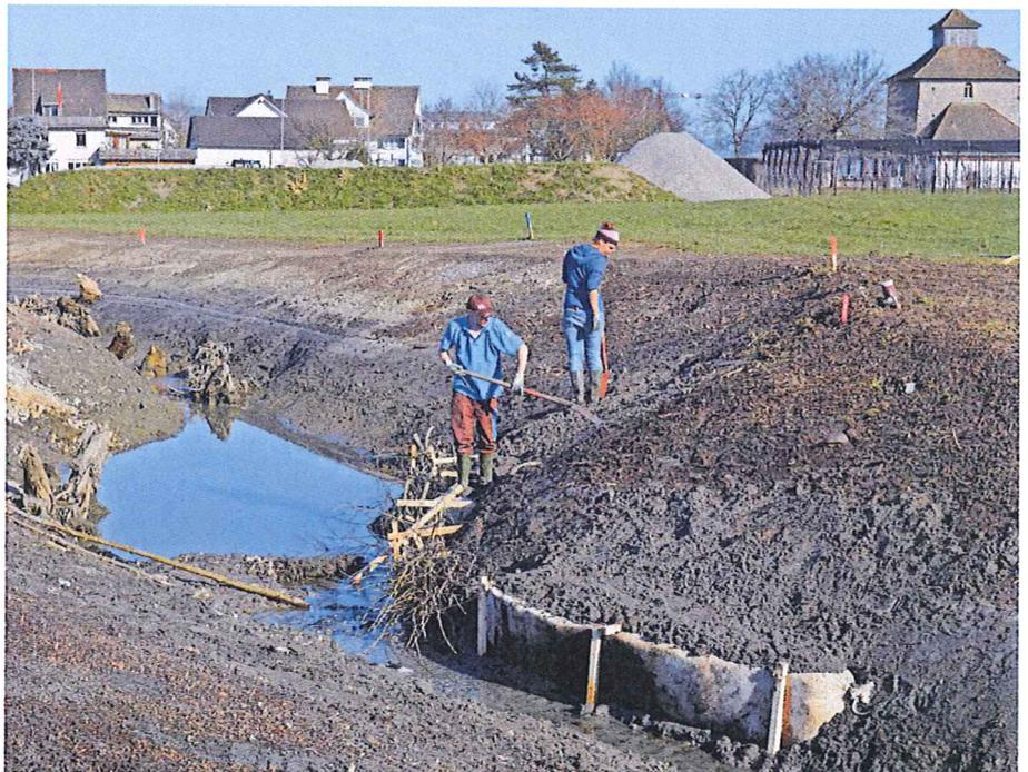
**Die Q-Faschinen wurden als Erosionsschutz des Uferbereichs bei besonders weichem Boden verbaut. Das Produkt überzeugt in der Anwendung durch den rationalen Einbau sowie die vielfältigen Verwendungsmöglichkeiten.**
