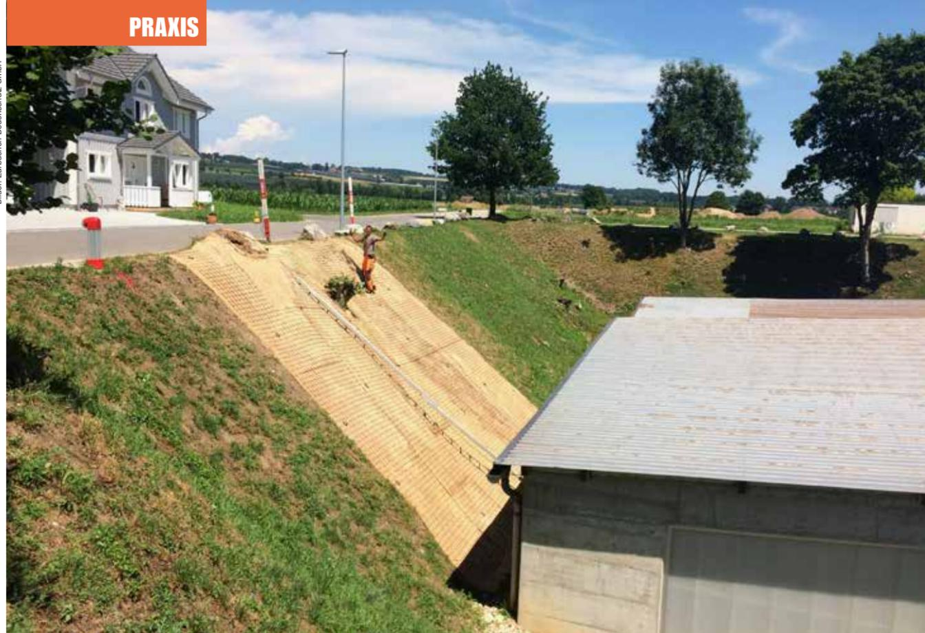
Bei besonders steilen oder steinschlaggefährdeten Böschungen reichen manchmal gewöhnliche Erosionsschutzmassnahmen nicht aus. Über die Geotextilien gespannte Stahlgitter (oben) oder Stahlflechte (unten) bieten dann zusätzliche Sicherheit.
