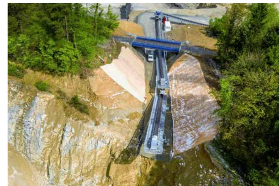
Im Steinbruch der Jura Cement in Wildegg AG: Nach dem Keileinschlag, der für den Bau einer Förderbandanlage nötig war, wird die Böschung mit Holzwollenetzen gesichert.
