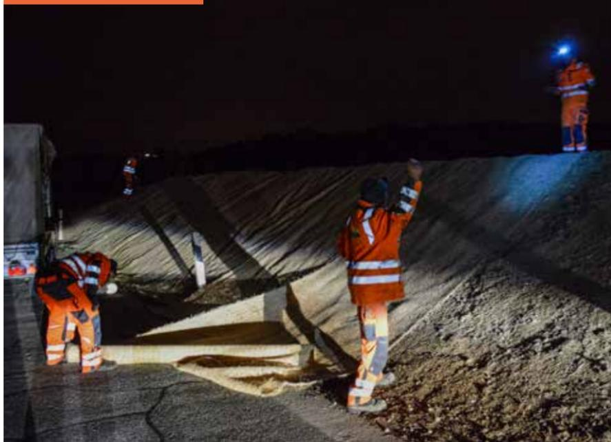
Eine Erosionsschutzmassnahme im Zeitraffer: Das Holzwollevlies wird auf dem Flughafen Zürich teilweise in Nachtarbeit verbaut (oben), das Saatgut zusammen mit Düngemitteln nass aufgespritzt (Mitte) und bereits nach neun Monaten spriesst es auf dem Damm sattgrün (unten).
