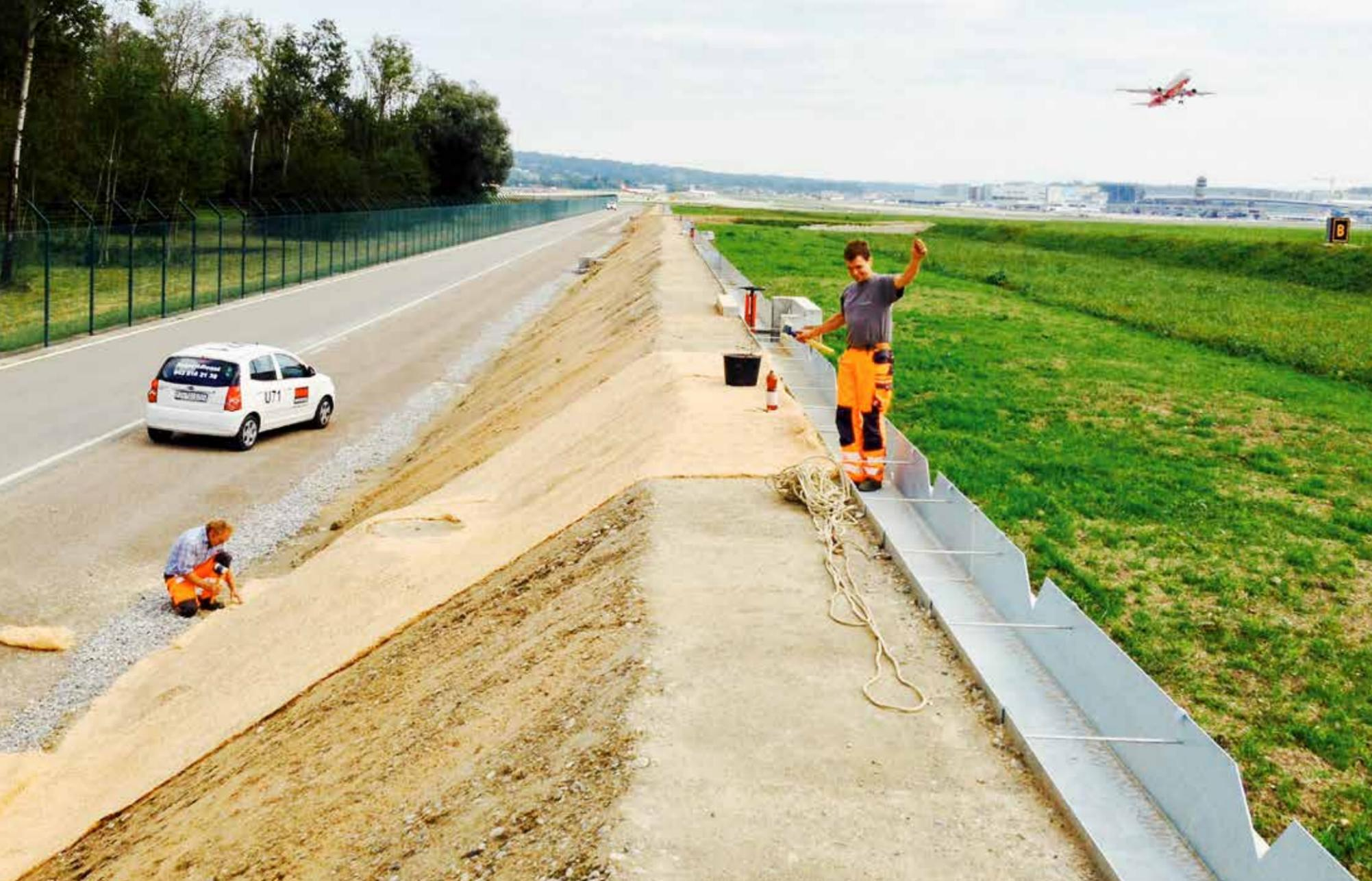
Ready for Take-off: Ein Damm auf dem Flughafengelände in Zürich wird mit einem Erosionsschutzvlies aus Schweizer Holzwolle eingepackt.
