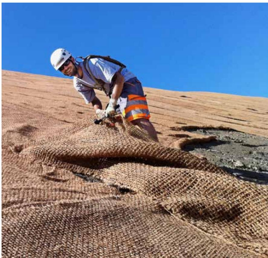
Das Verlegen der Erosionsschutzmatten ist Handarbeit: Diese Böschung in Lufingen ZH wird mit einem Kokosnetz gesichert.
