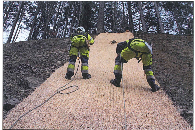
Abbildung 2: Zwei Arbeiter befestigen an einem steilen Hang in Wattwil Holzwollevliese, um eine schnelle Begrünung zu ermöglichen. Figure 2: Deux travailleurs fixent sur un versant raide à Wattwil des nappes de laine de bois afin de permettre une végétalisation rapide.
