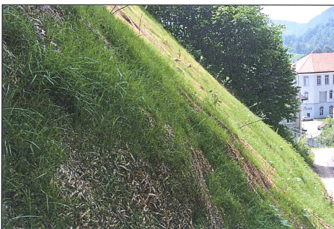
Abbildung 3: Bereits einige Wochen später zeigt sich der Hang im grünen Kleid. Die Holzwollevliese sind kaum mehr sichtbar. Figure 3: Quelques semaines plus tard, le versant est déjà recouvert de végétation. Les nappes de laine de bois sont à peine visibles.
