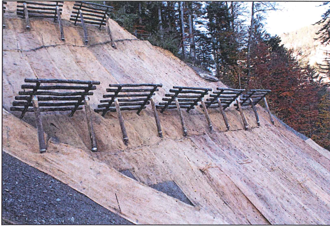
Abbildung 1: Holzwollevliese schützen den Hang beim neu erstellten Trasse der Stoos- Standseilbahn vor Erosion und begünstigen das schnelle Aufkommen des ausgebrachten Saatguts. Figure 1: Les couches de laine de bois protègent la pente sur le nouveau tracé du funiculaire de Stoos contre l'érosion et favorisent l'émergence rapide des semences.
