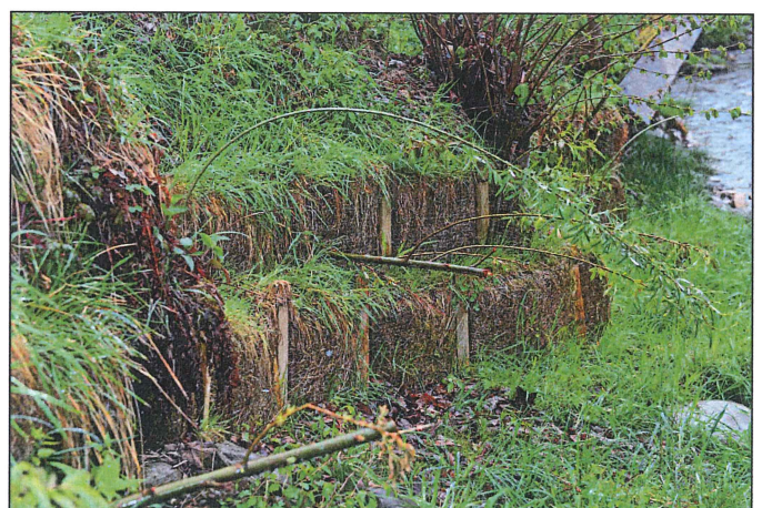
Abbildung 4: Faschinen aus Holzwolle haben sich bei der Ufersicherung gut bewährt. Figure 4: Les fascines en laine de bois se sont révélés très efficaces pour la protection des berges.
