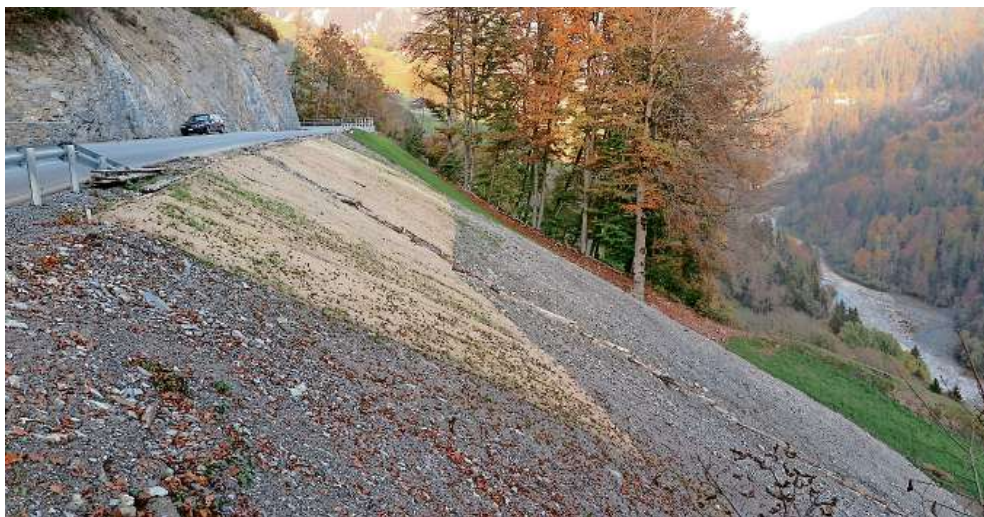
Bereits nach einem Monat spriesst das erste Grün aus den Holzwolle-Vliesen aus der Böschung oberhalb von Schiers. Pressebilder
