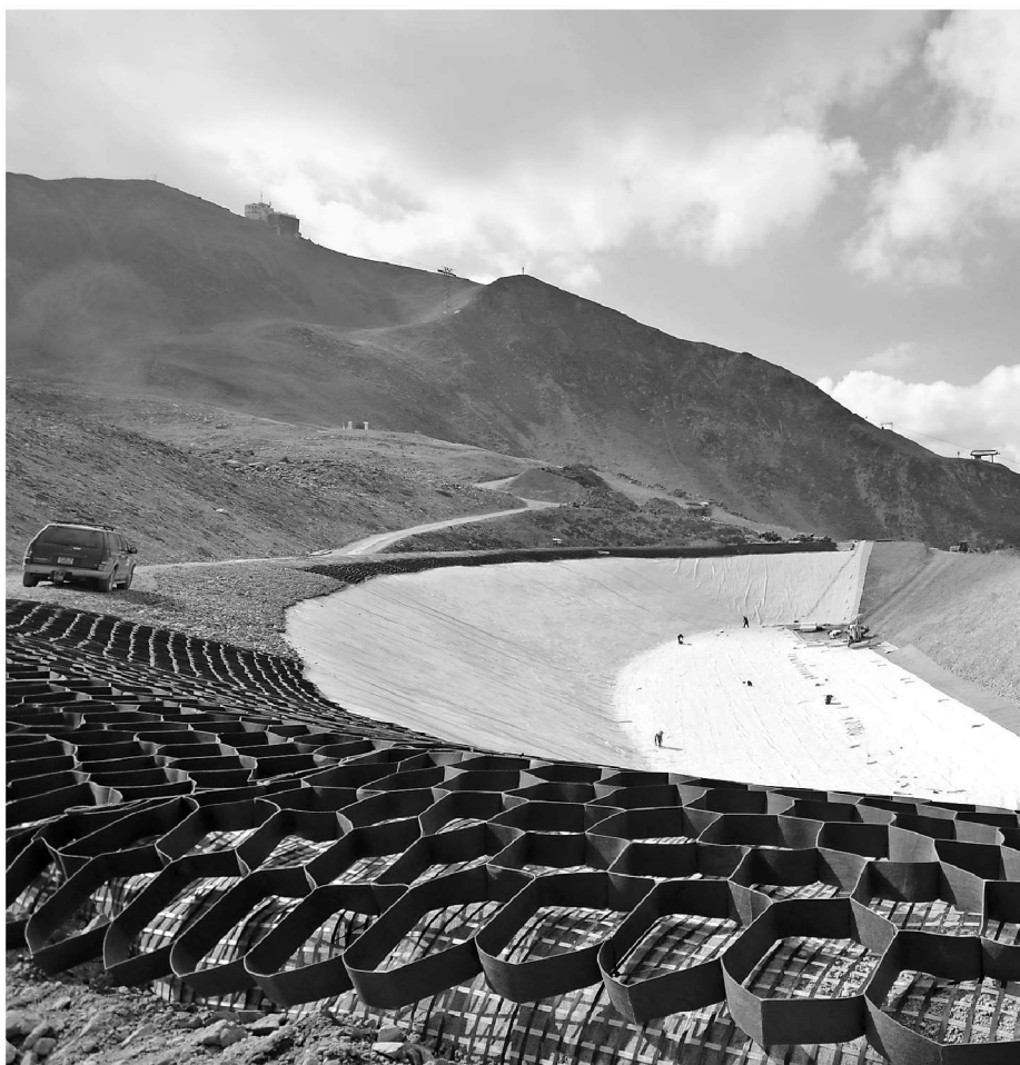
Geokunststoffe in verschiedensten Formen und Funktionen beim Bau des Speichersees Brämabüel, Davos. Foto: zvg (IBAR/Schoellkopf AG)
