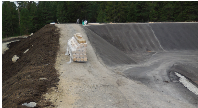
Erosionsschutz mit Howolis für Wasserreservoir im Gebirge
