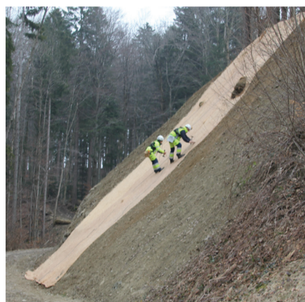
Erosionsschutz mit Howolis - Vorher
