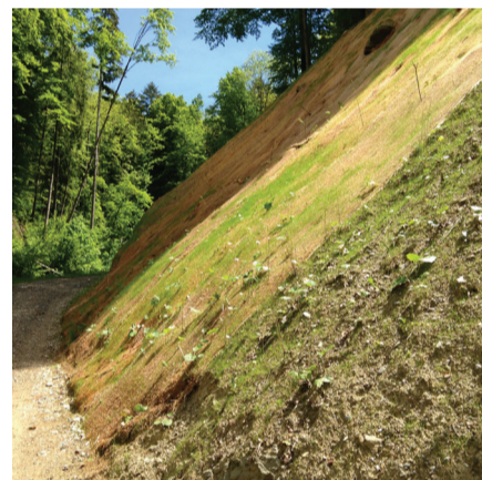
Erosionsschutz mit Howolis - Während
