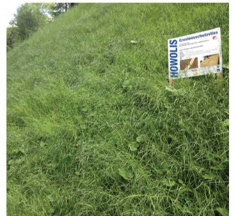
Erosionsschutz mit Howolis - Nachher
