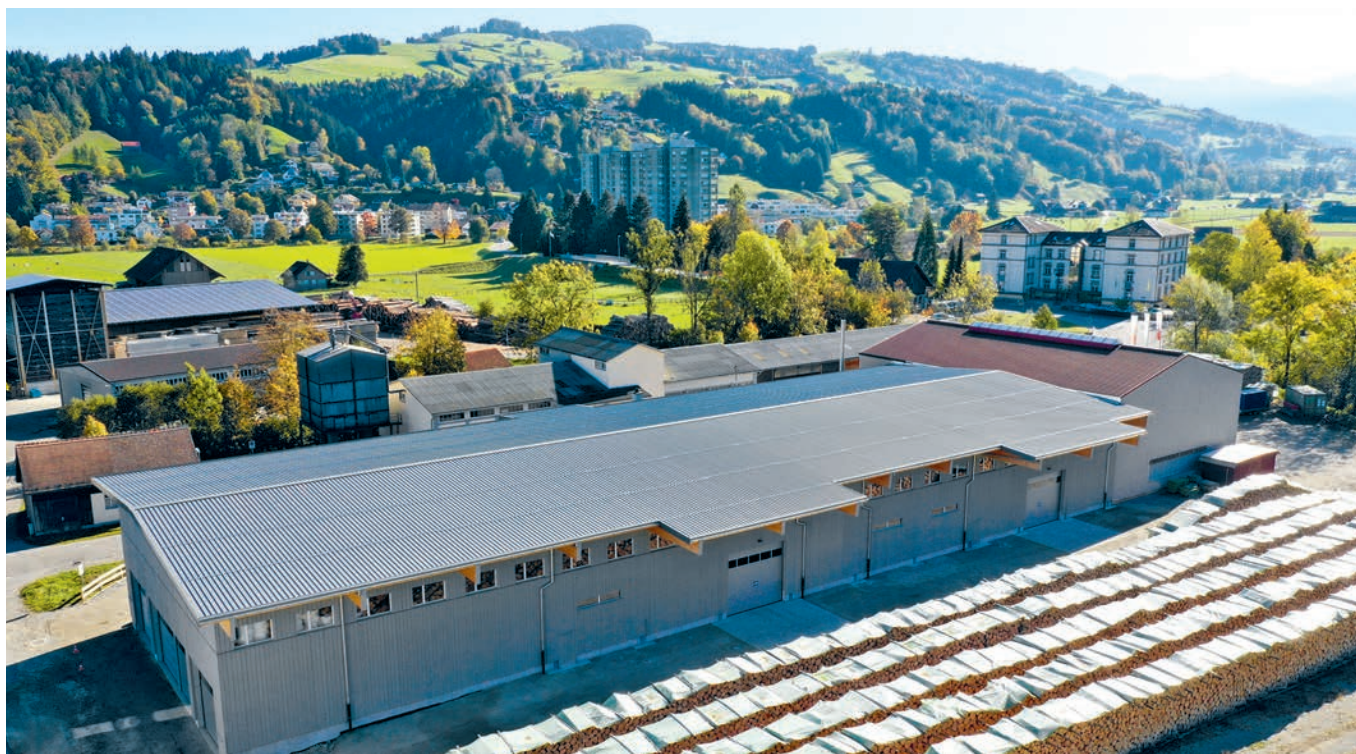
Die Lindner Suisse GmbH produziert seit fast schon 100 Jahren Holzwolle. Der Produktionsort in Wattwil wurde nun mit einer neuen Lagerhalle erweitert, um für zukünftige Anforderungen gewappnet zu sein.
