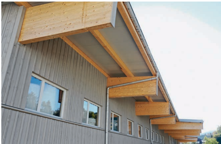
Ein grosser Dachüberstand und die auch aussen sichtbaren Leimbinder sind signifikante Gestaltungselemente der neuen Werkhalle. Das Grau der Fassade kontrastiert zum warmen Holzton.
