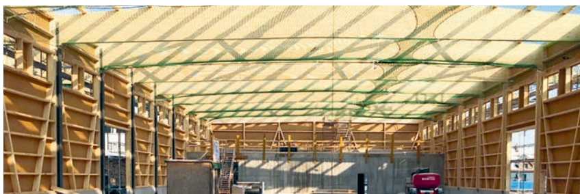
Das Hallentragwerk mit 24,5 Metern Spannweite ermöglicht eine stützenfreie Nutzfläche von 2000 m².
