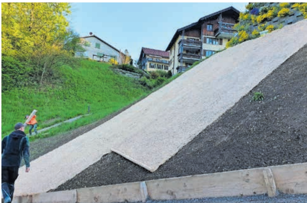
Ver mehrt, wie hier bei einer Überbauung in Lichtensteig, wird auch im Toggenburg Holzwolle eingesetzt, um einen Hang vor einer Begrünung zu stabilisieren. Bilder: PD
