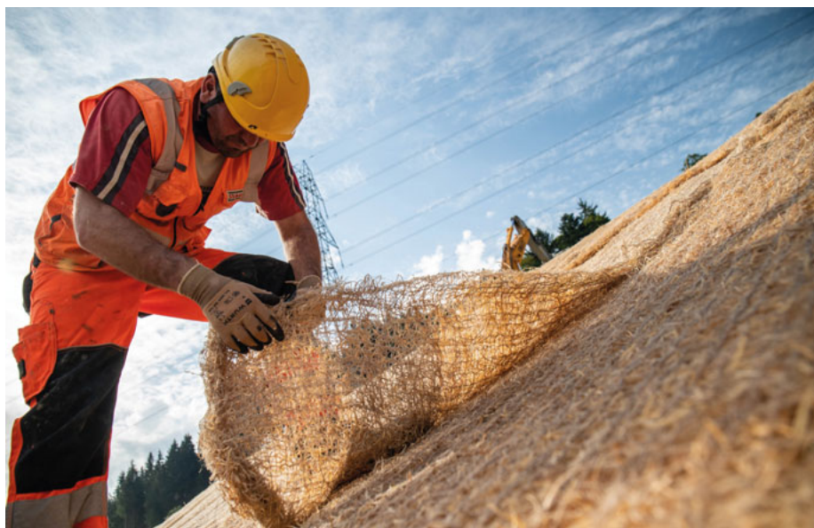
Verlegung der Holzwollevliese als Erosionsschutz (Foto: Thomas Rickenmann).
