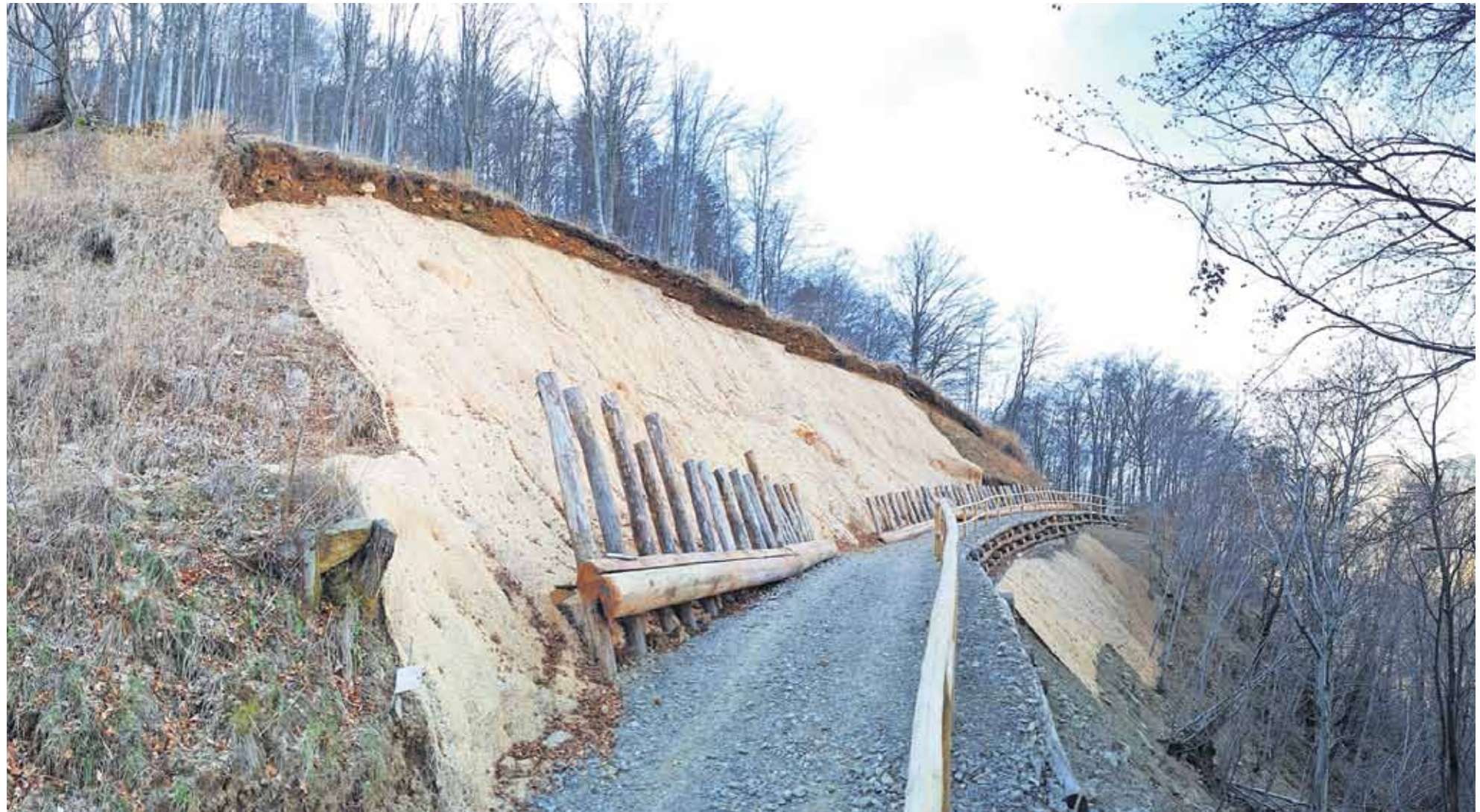
Scarpata ricoperta con manto protettivo a Bogno. (© IST - SUPSI)
