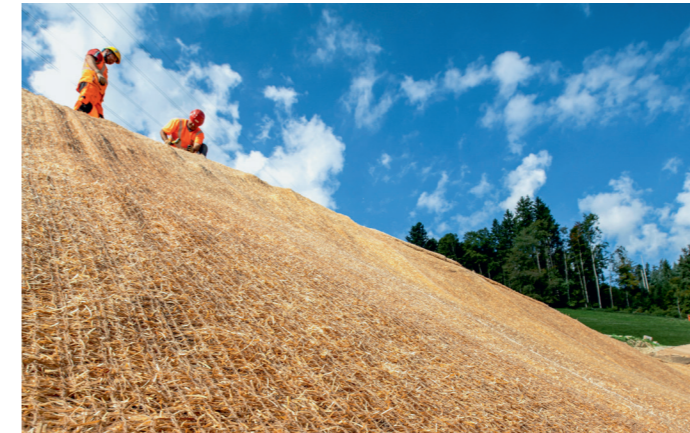
Besonderes Augenmerk gilt der Kombination des Holzwollevlieses mit einer biodiversitätsfördernden, naturgemässen Begrünung aus lokalem Saatgut. Bilder: Lindner Suisse (links), Andreas Bosshard Ö+L GmbH
