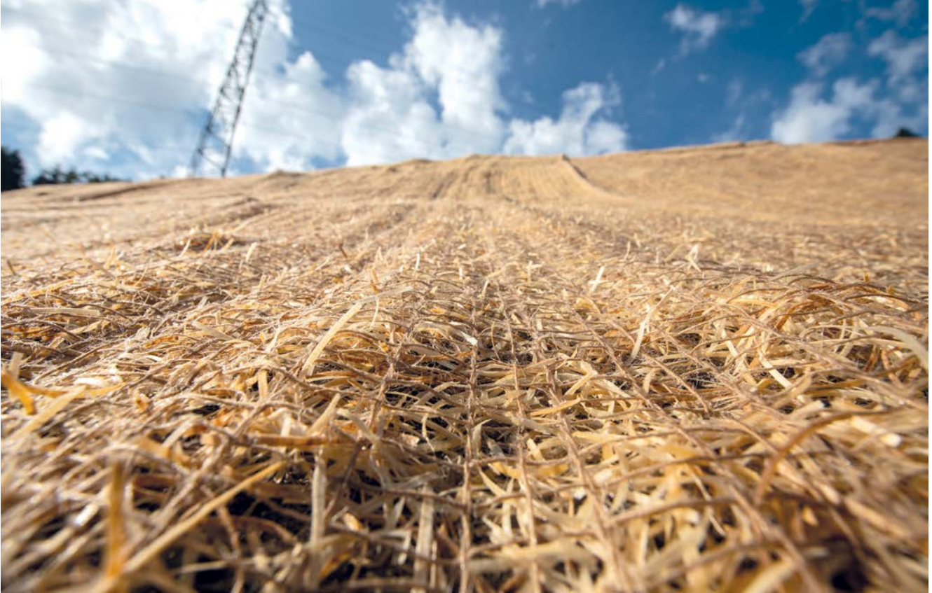
Verlegtes Holzwollevlies an einer Böschung.
