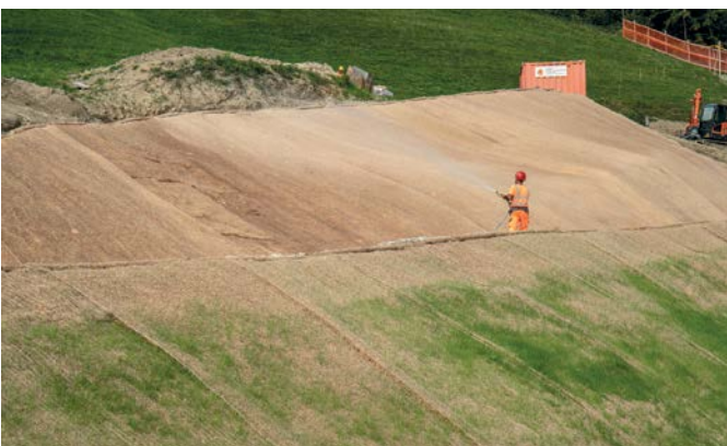
Verlegtes Holzwollevlies an einer Böschung.
