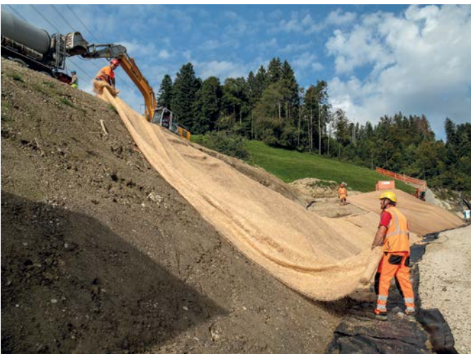
Anbringung des Erosionsschutzes aus Holzwolle.
