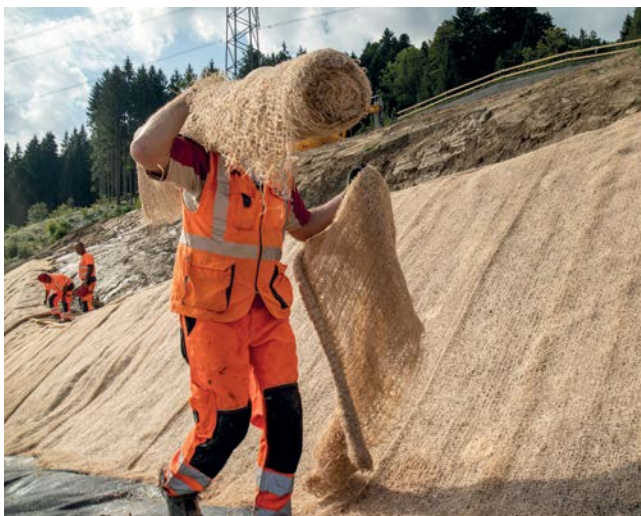
Verlegen des Holzwollevlieses ab der Rolle.
