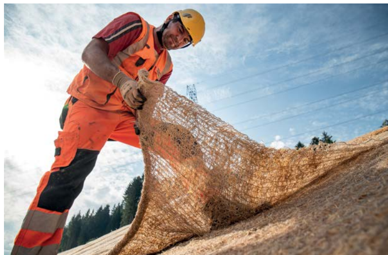
Verlegen am Hang.
