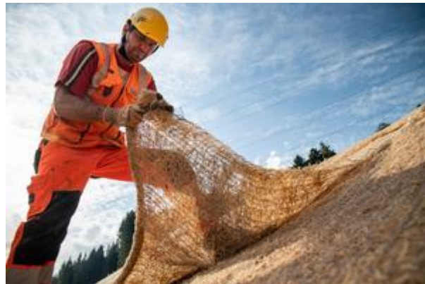
Abb. 4 - La fase di posa delle stuoie in pendio.
