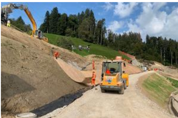
Abb. 5 - Panoramica della realizzazione della protezione contro l'erosione tramite posa di stuoie di lana di legno.
