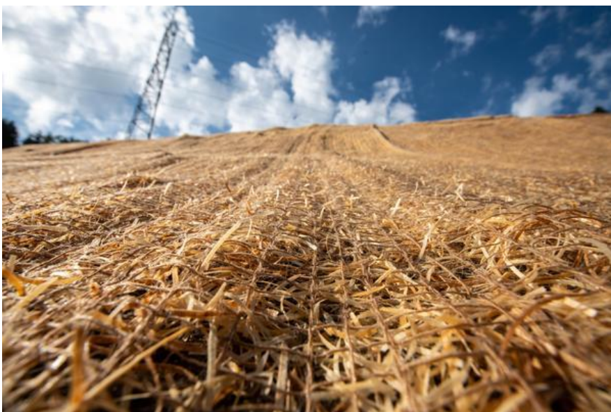
Abb. 7 - Dettaglio di una stuoia di lana di legno posata su un pendio.
