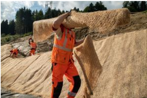
Figb. 3 - Operazioni di trasporto e posa delle stuoie di lana di legno, prodotte sotto forma di rotoli.
