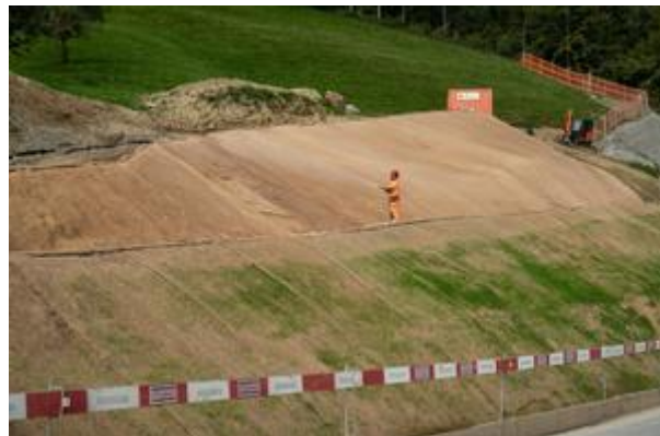
Abb. 6 - Un pendio protetto dall'erosione grazie a stuoie composte da lana di legno.
