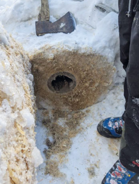
Geöffnete Rolle beim Kontrollgang.
