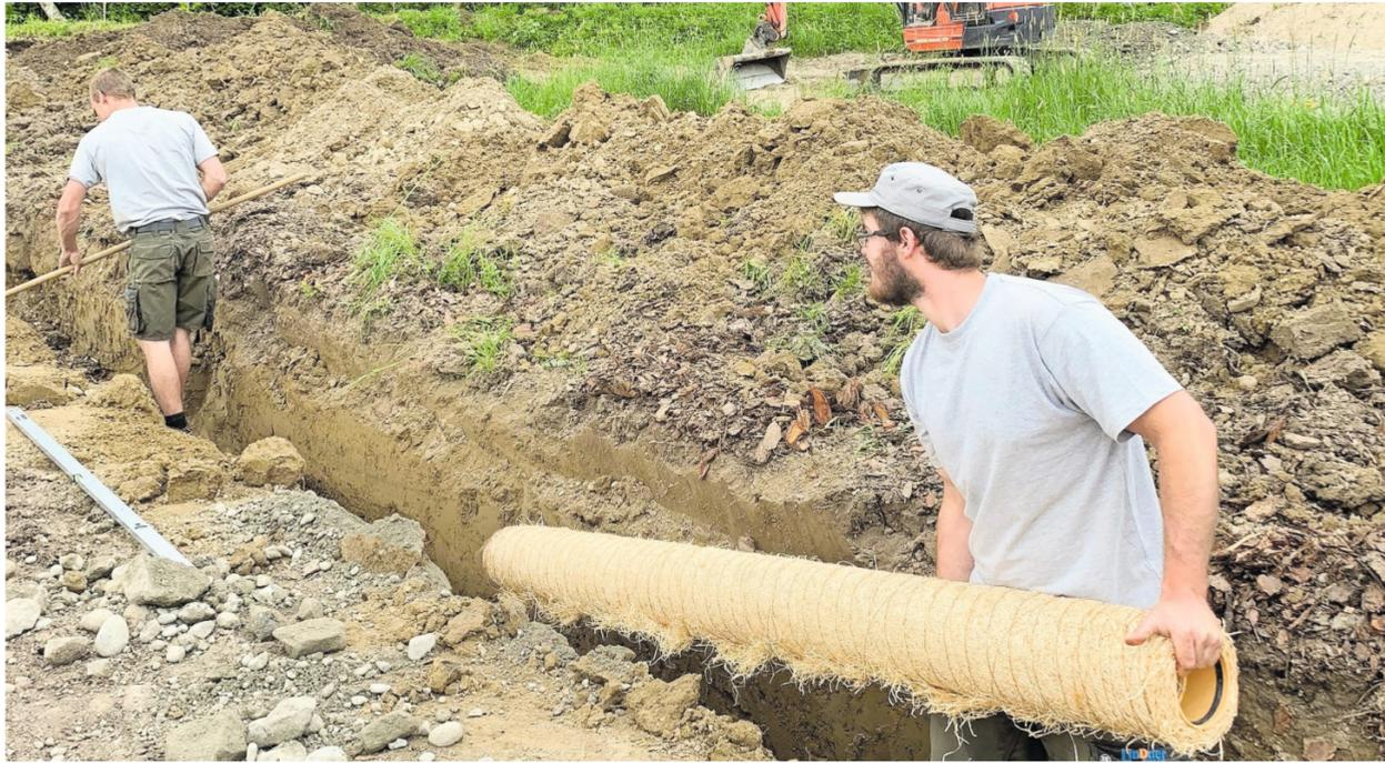
Das Handling ist bei der Entwicklung wichtig, die mit Holzwolle ummantelten Drainagerollen sollen einfach und ohne grossen Maschineneinsatz verlegt werden können. Bilder: PD
