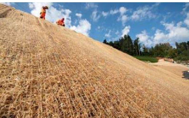
Abb 6.: Die Holzwollevliese werden mit Holzhaften befestigt. Fig. 6 : Les tapis en laine de bois sont fixés à l'aide d'attaches en bois.
