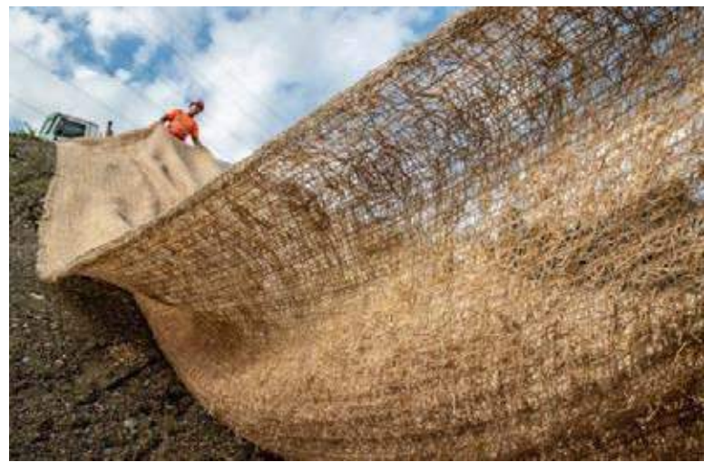
Abb. 3: Verlegen der Holzwollevliese ist Handarbeit. Fig. 3 : La pose d'une natte en laine de bois est un travail manuel.
