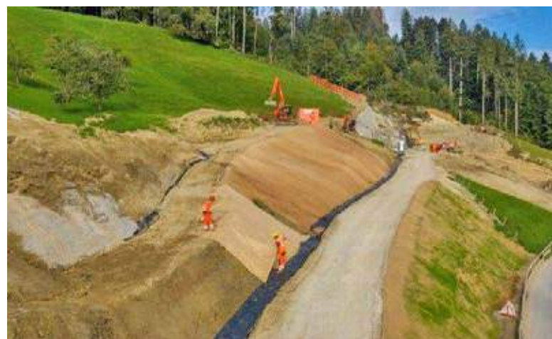
Abb. 7: Verlegte Holzwollevliese zur Böschungssicherung in der Ostschweiz. Fig. 7 : Pose de la natte en laine de bois pour la consolidation de pentes en Suisse orientale.
