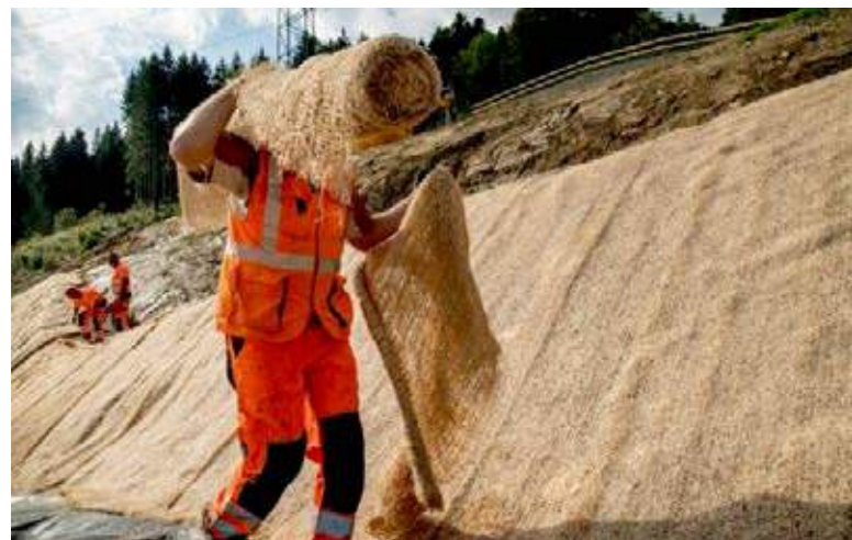
Abb. 5: Durch das geringe Gewicht sind die Holzwollevliese leicht zu verlegen. Fig. 5 : Grâce à leur faible poids, les tapis en laine de bois sont faciles à poser.
