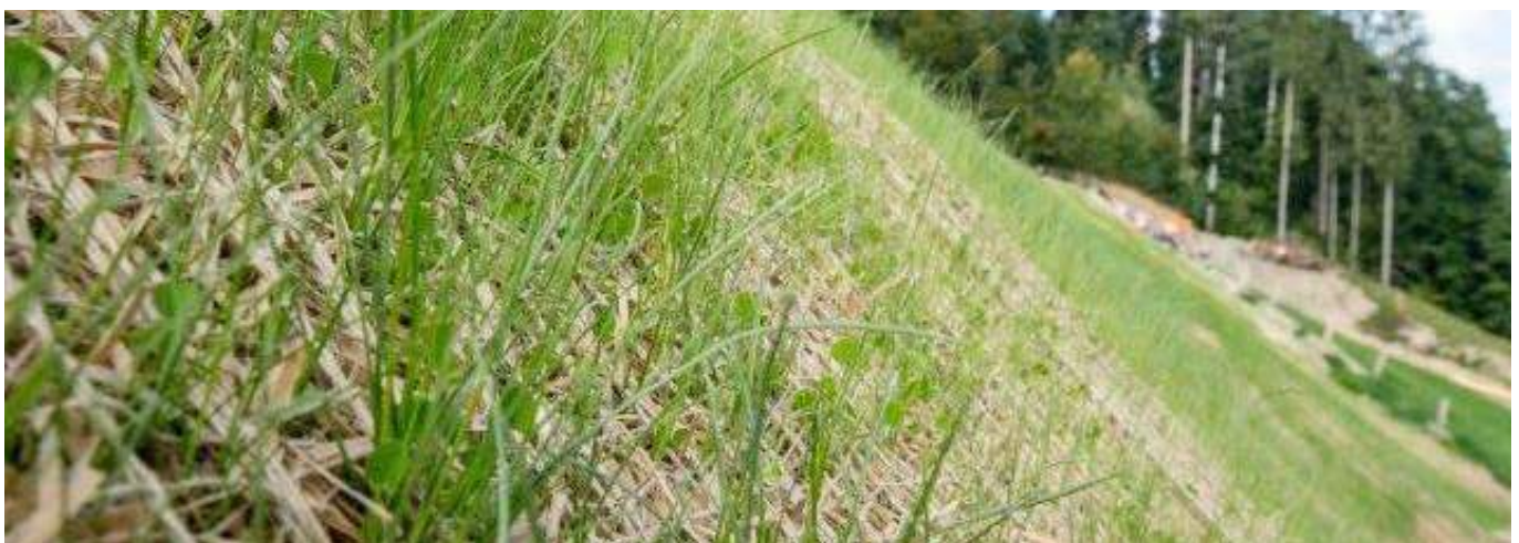
Abb. 9: Böschung nach Auflaufen der Ansaat (nachher). Fig. 9 : Talus après la levée de semis (après).
