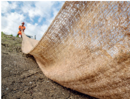
Figur 8 Erosionsschutz mit Böschungsmatten aus Holzwolle.
