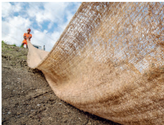
Figure 8 Protection contre l'érosion avec des nattes en laine de bois.
