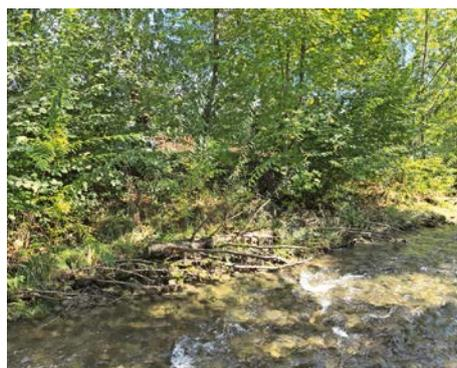
Situation beim Pilotprojekt Wattwil (links) kurz nach der Installation mit Raubbaum und Holzwohle-Faschinen am 23.05.2022 und rechts am 07.10.2024.
