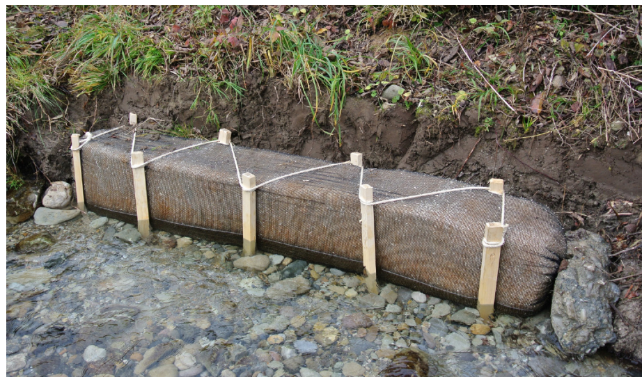
Die Holzwolle Q-Faschine wird zur Böschungsstabilisierung, als Ufersicherung im Wasserbau und für weitere Bereiche eingesetzt. Die Fachhochschule Graubünden hat bei einem Forschungsprojekt die Eignung dafür umfangreich geprüft. Bilder: Fachhochschule Graubünden
