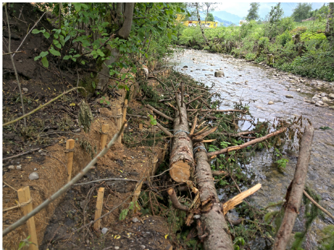
Die Situation beim Pilotprojekt in Wattwil kurz nach der Installation mit Raubaum und Holzwolle Faschinen.
