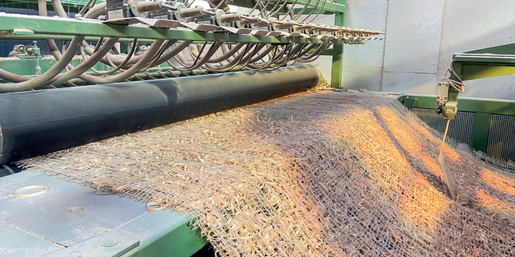
Ci-dessus: Le tissage de la laine de bois. Ci-contre, haut: Pose de tapis anti-érosion. Ci-contre, centre: installation de fascines pour stabiliser un talus et favoriser une reprise de végétation.
