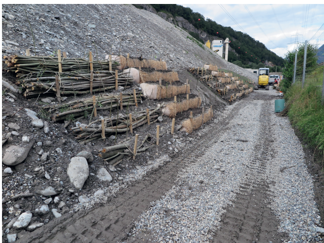
Abbildung 9: Blickrichtung Nordost; A) eingebaute Faschine (Aufnahme vom 5.8.2021); B) Entwicklung der Begrünung nach ca. einem Jahr (Aufnahme vom 26.9.2024). Figure 9: Vue vers le nord-est ; A) fascines installées (photo prise le 5.8.2021) ; B) développement de la végétalisation après environ un an (photo prise le 26.9.2024).
