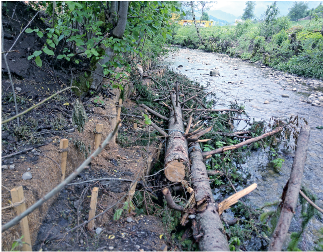
Abbildung 12: Situation beim Pilotprojekt Wattwil [A] kurz nach der Installation mit Raubbaum und Holzwollefascinen am 23.5.2022 und [B] am 7.10.2024. Figure 12 : Situation dans le cadre du projet pilote Wattwil [A] peu après l'installation avec des arbres en épi et des fascines en laine de bois le 23 mai 2022 et [B] le 7 octobre 2024.
