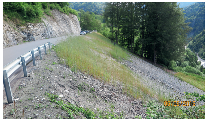
Abbildung 4: Kontrolle 6.6.2016, Projekt Schiers Graubünden. Dank gutem Erosionsschutz durch Holzwolle muss bei der Ansaat in der Regel kein Dünger für die Beschleunigung der Begrünung eingesetzt werden, wodurch die Artenvielfalt und die langfristige Stabilität der Vegetation nicht beeinträchtigt wird.
