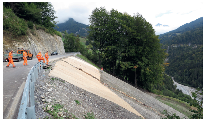
Abbildung 3: Howolis Verlegung am 15.9.2015, Projekt Schiers Graubünden.
