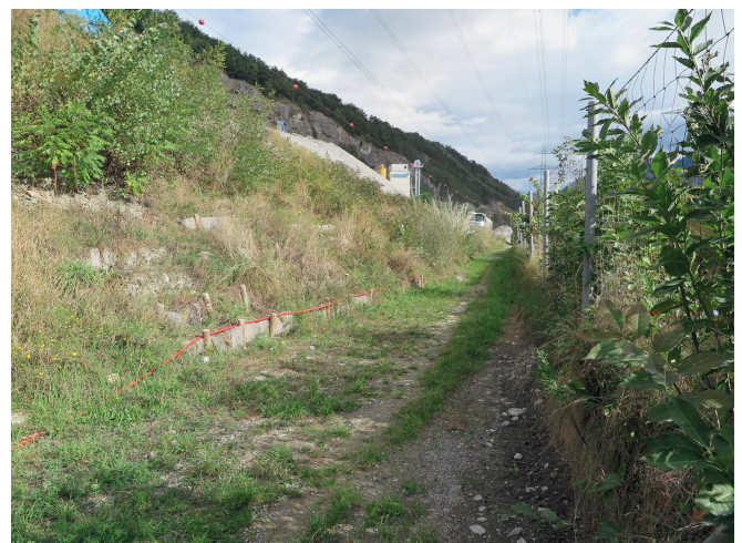
Abbildung 9: Blickrichtung Nordost; A) eingebaute Faschine (Aufnahme vom 5.8.2021); B) Entwicklung der Begrünung nach ca. einem Jahr (Aufnahme vom 26.9.2024). Figure 9: Vue vers le nord-est ; A) fascines installées (photo prise le 5.8.2021) ; B) développement de la végétalisation après environ un an (photo prise le 26.9.2024).
