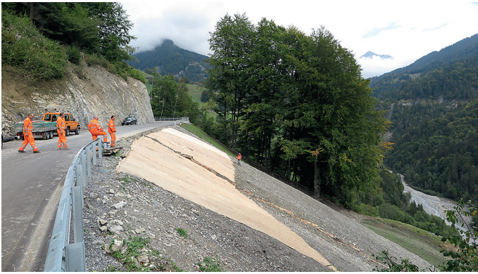
Abb. 2: Verlegung Matten am 15.9.2015, Projekt Schiers Graubünden
