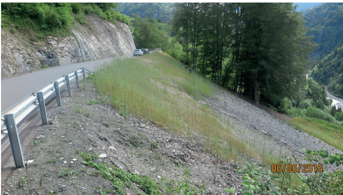
Abb. 4: Kontrolle 6.6.2016, Projekt Schiers Graubünden Dank gutem Erosionsschutz durch Holzwolle muss bei der Ansaat in der Regel kein Dünger für die Beschleunigung der Begrünung eingesetzt werden, wodurch die Artenvielfalt und die langfristige Stabilität der Vegetation nicht beeinträchtigt wird.
